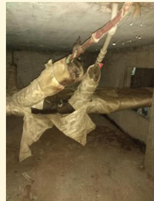
Теплоізоляція трубопроводів у підвалі
