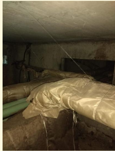
Теплоізоляція трубопроводів у підвалі
