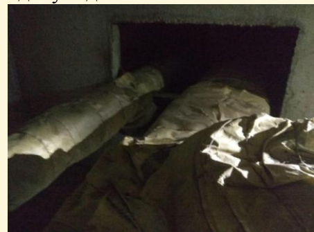
Теплоізоляція трубопроводів у підвалі
