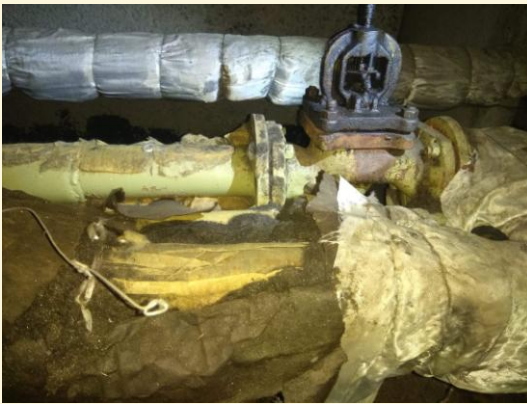
Теплоізоляція трубопроводів у підвалі
