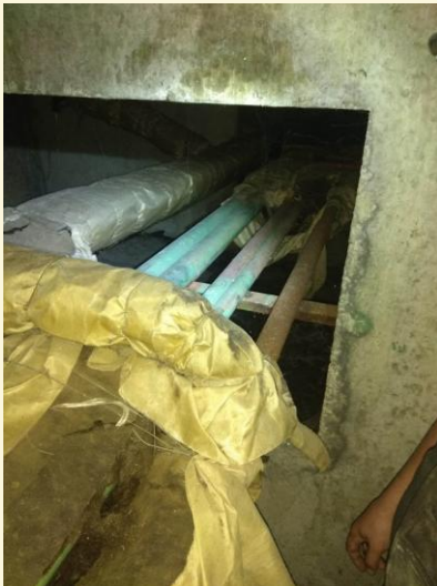
Теплоізоляція трубопроводів у підвалі
